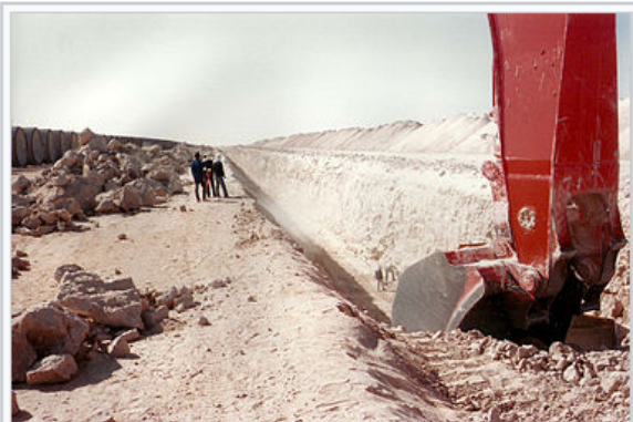
Pembangunan Sungai Buatan Raya
